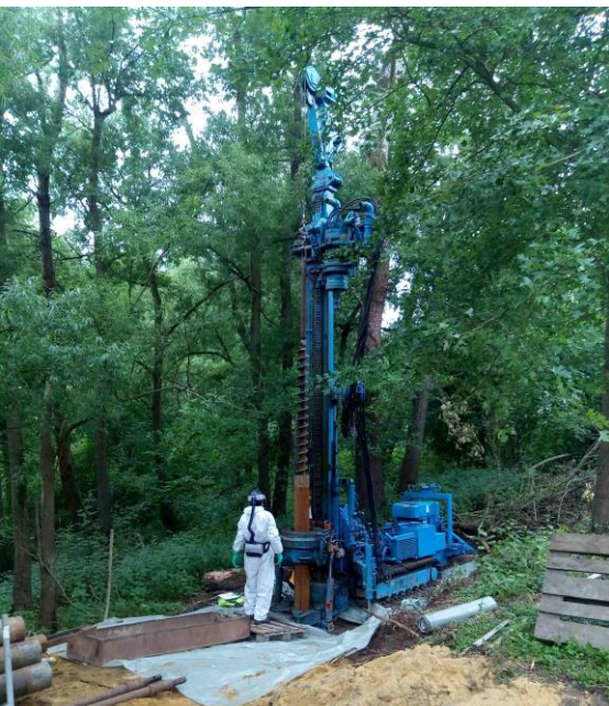
Abb. 1: Trockenbohrgerät im Einsatz
