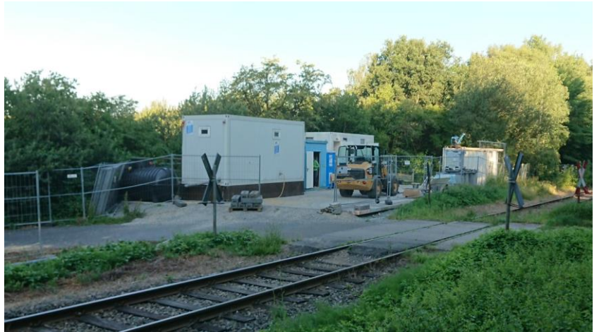
Abb. 4: Baustelleneinrichtung am Bahnübergang Unterberg
