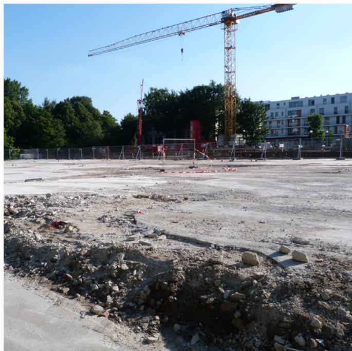
Abb. 11: Vorbereitung der Fläche für die Herstellung der Baugrube
