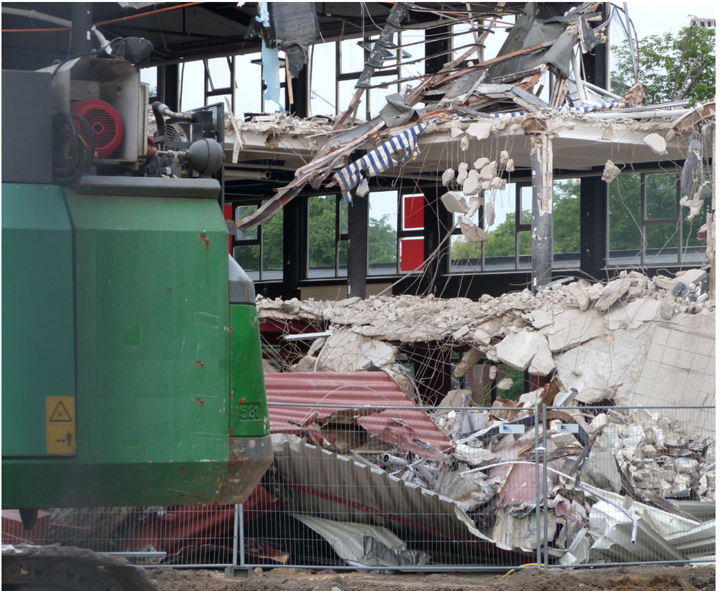
Abb. 12: Rückbau des ehemaligen Wäschereigebäudes
