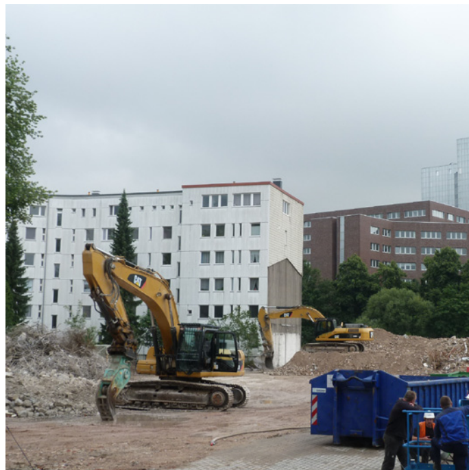
Abb. 10: Rückbau des ehemaligen Wäschereigebäudes
