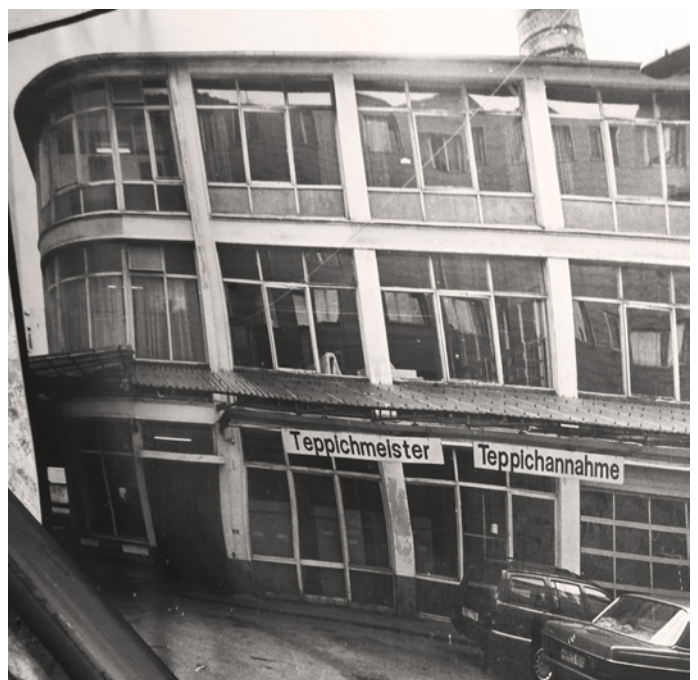
Abb. 03: Wäscherei Wulff, Außenansicht
