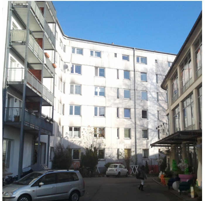
Abb. 26: Angrenzende Wohngebäude zur Jarrestraße und Großheidestraße
