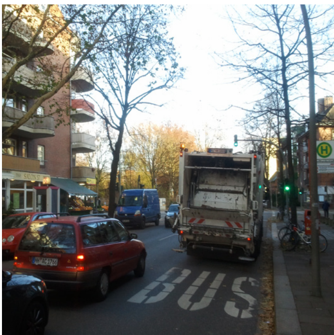
Abb. 27: Jarrestraße im Bereich der Baustellenzufahrt
