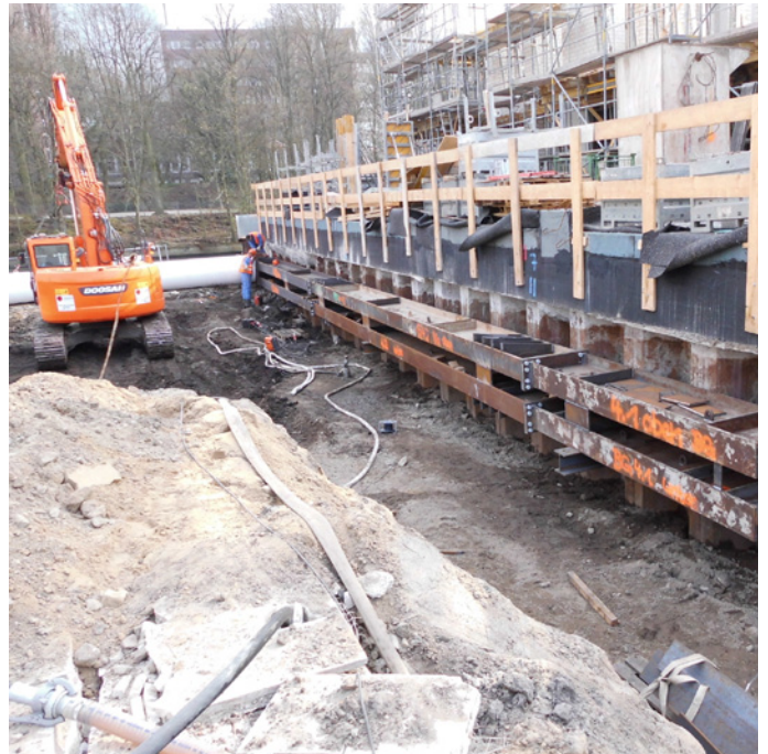
Abb. 23: Spundwand zur Nachbarbaustelle
