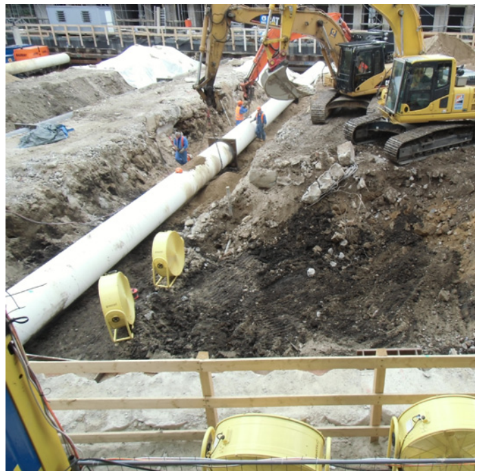
Abb. 21: Einbau der Steifen
