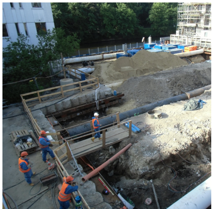
Abb. 24: Kleinteiliges Vorgehen beim Bodenaustausch
