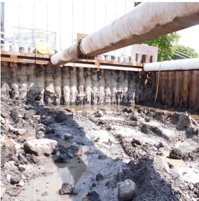
Abb. 22: Gurtungen und Steifen zur Sicherung der Statik
