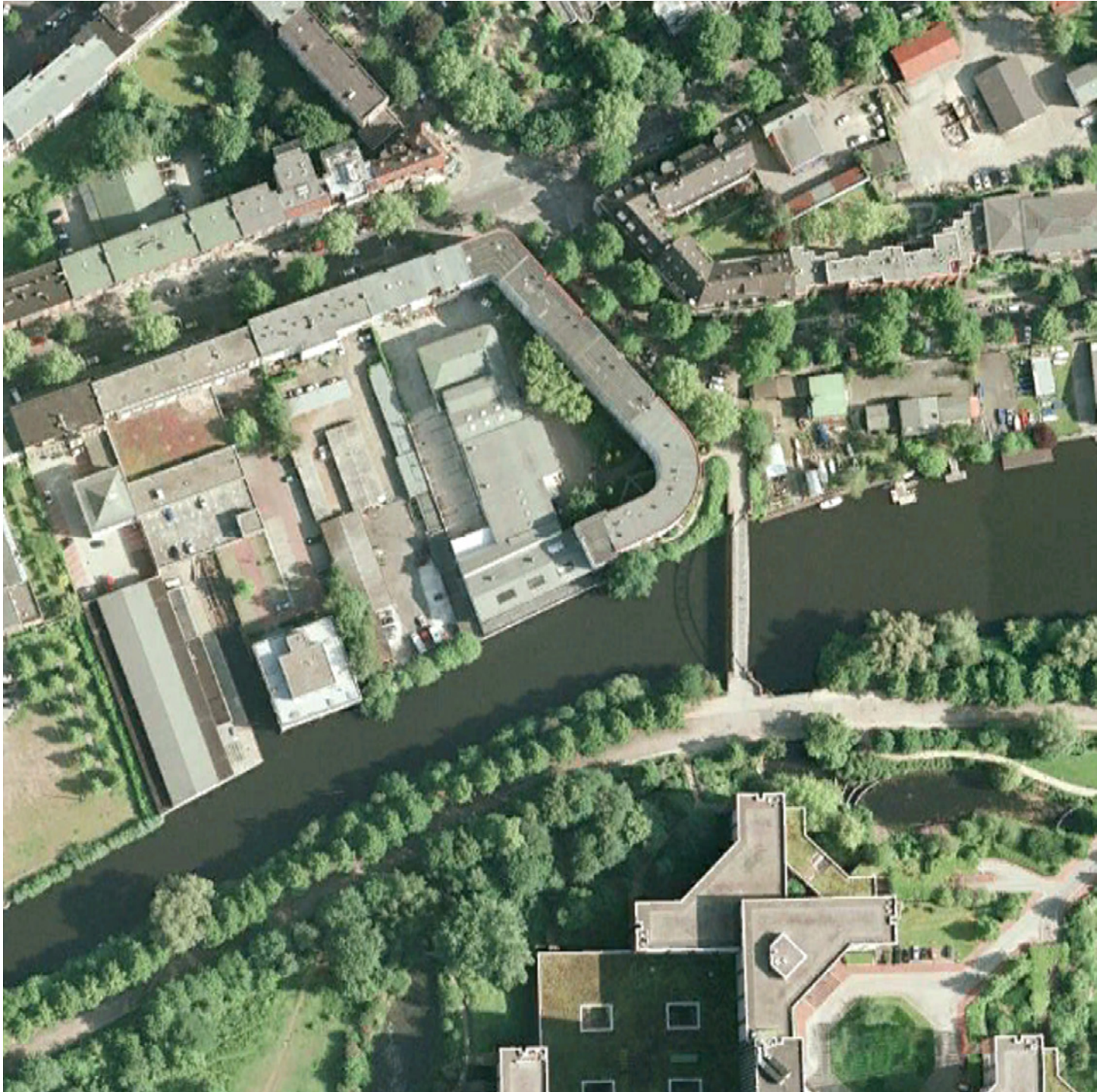
Abb. 01: Luftbild Jarrestraße, Großheidestraße, Osterbekkanal
