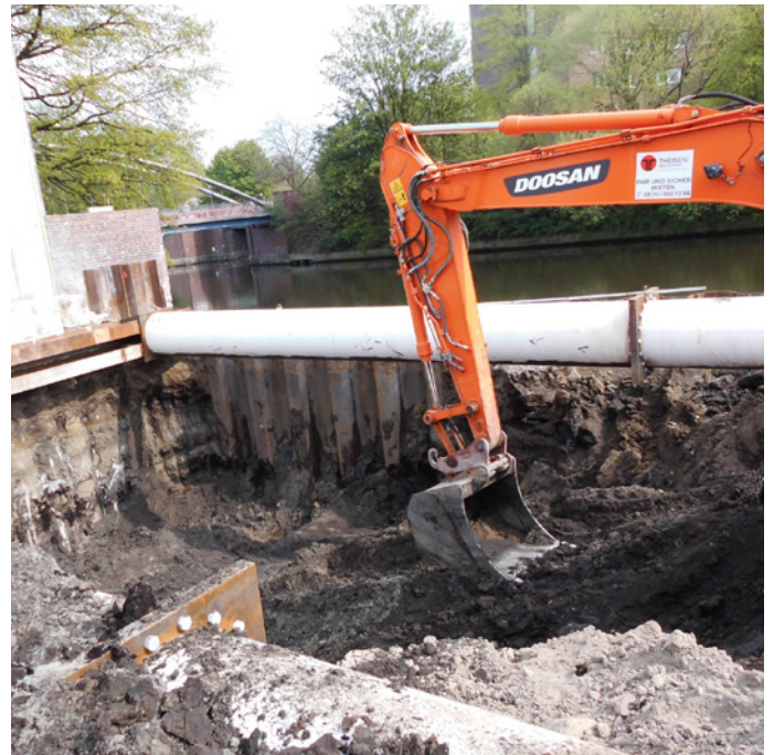
Abb. 20: Austausch des Bodens am Osterbekkanal
