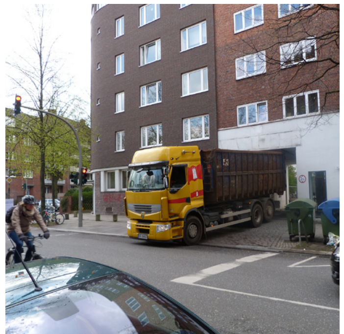
Abb. 25: Tordurchfahrt zur Baustelle
