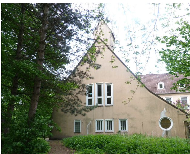
Blick auf die „Notkirche“
