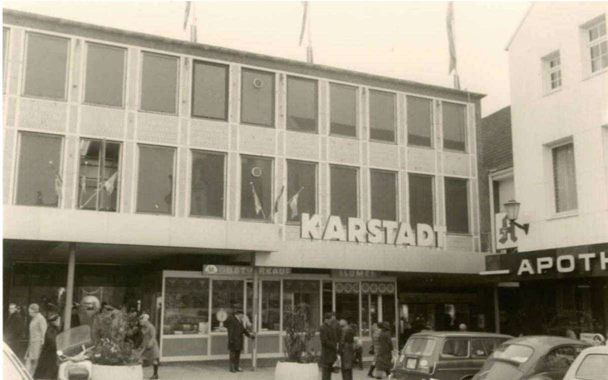
Abb. 03: Ansicht des Hertie-Kaufhauses vom Altstädter Markt, ca. 1972 / 1973 (Quelle: Stadt Rendsburg)
