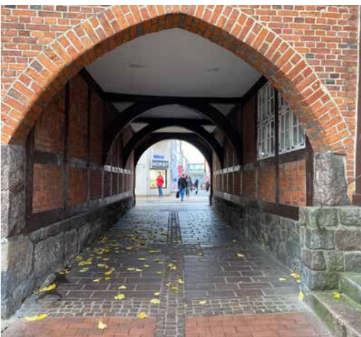
Abb. 23: Durchgang Rathaus zur Hohen Straße
