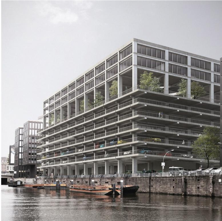
Der Entwurf sieht die Anpassung der baulichen Struktur an neue Nutzungen vor und verändert damit die Substanz und das Erscheinungsbild des Gebäudes in erheblichem Maß. Die Fassade wird rückgebaut, das Gebäude wird um drei Geschosse aufgestockt. Es entstehen durch Einschnitte in das Gebäude und die Öffnung der Rotundenkuppel zwei Lichthöfe bis zum dritten Obergeschoss.
