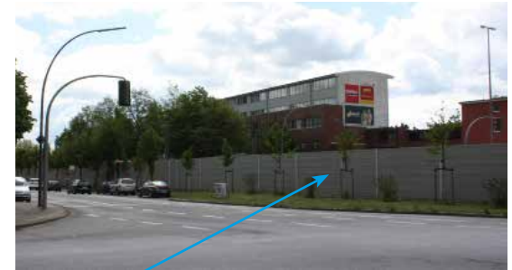
Lärmschutzwand Bahntrasse (Blick aus Richtung Schloßstraße)
