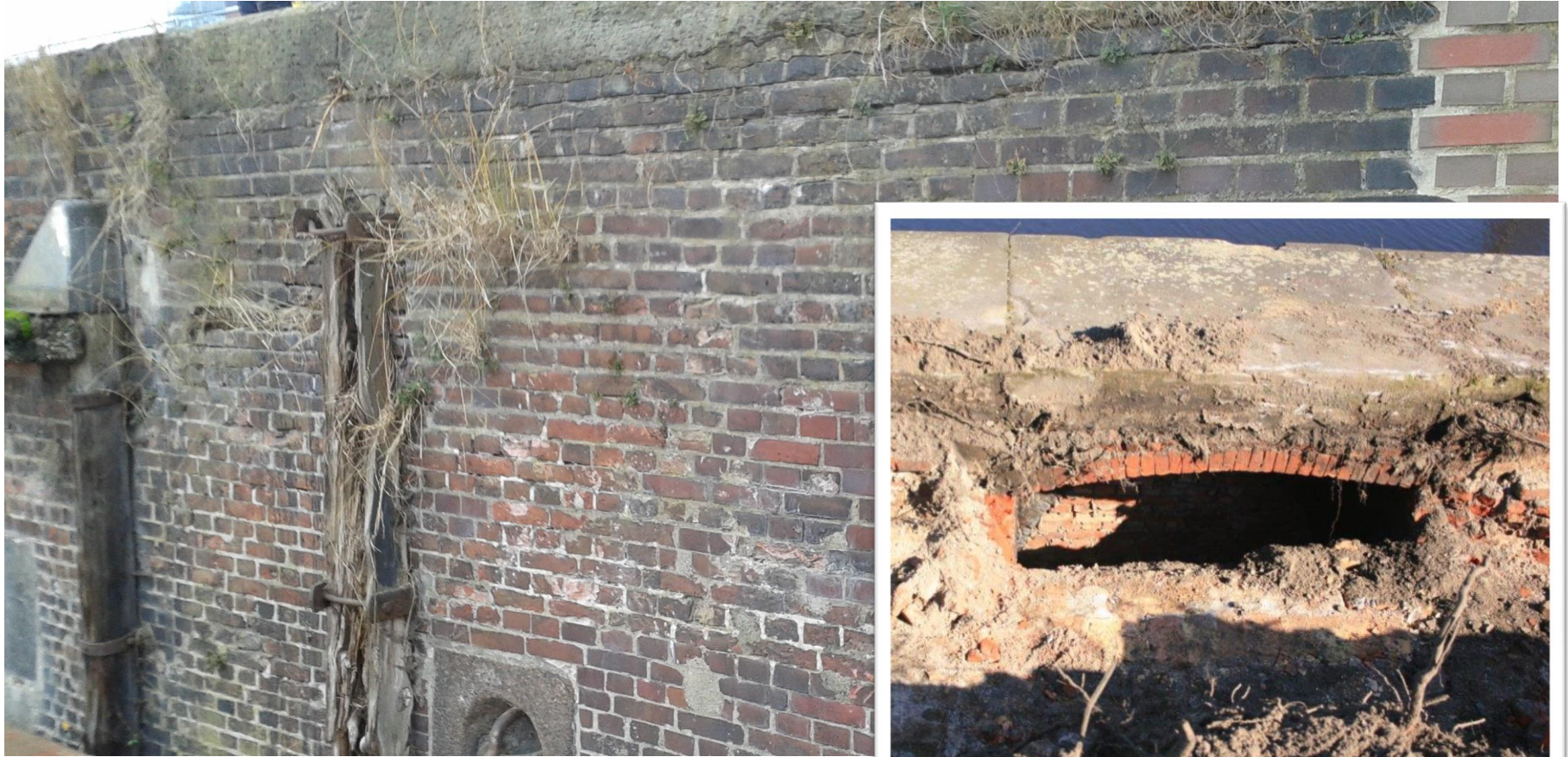
Kaimauersanierung Östl. Bahnhofskanal Bausumme: unbekannt Baubeginn/Fertigstellung: unbekannt
