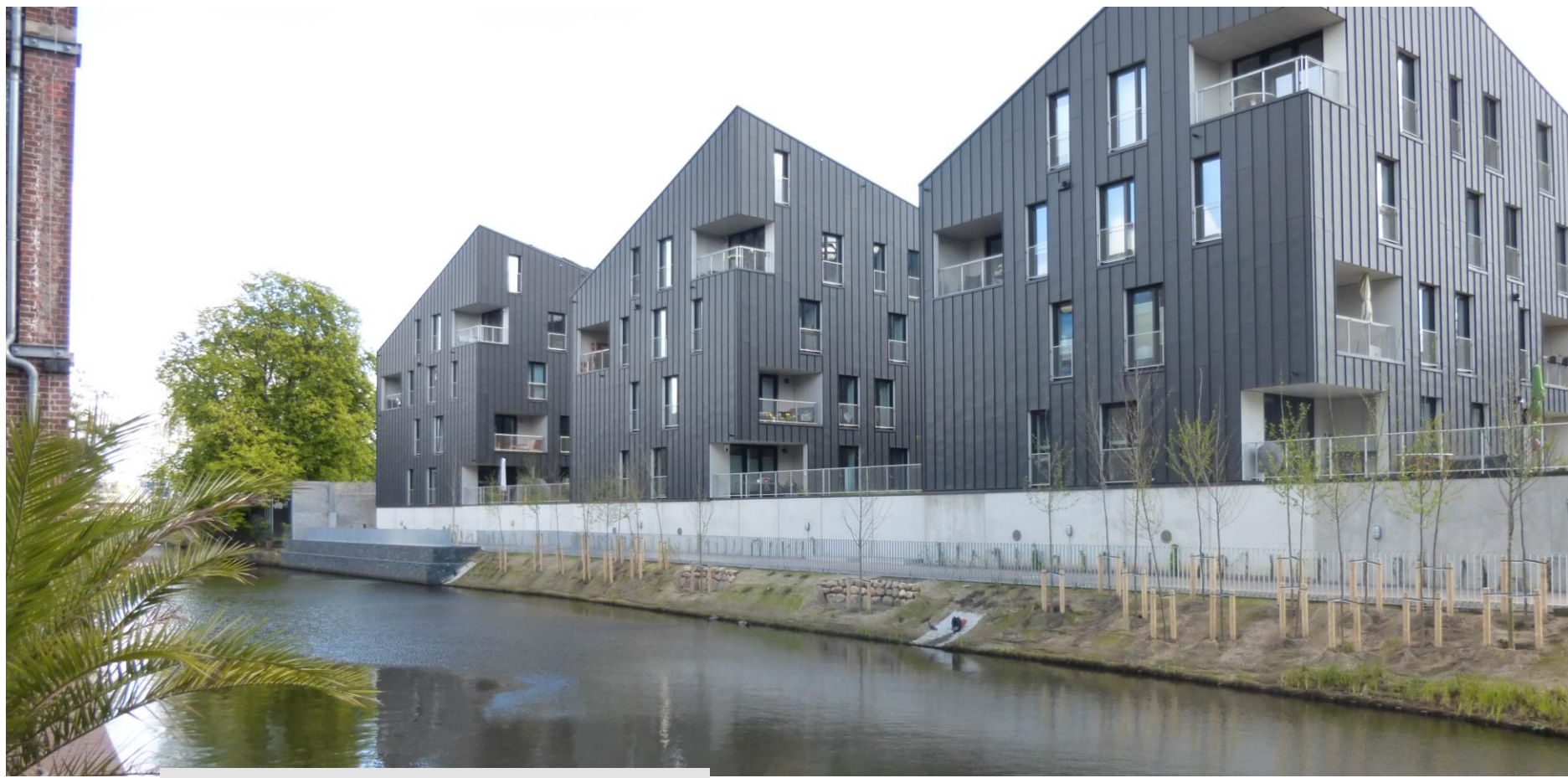
Ufer Kaufhauskanal Bausumme: ca. 200.000 Euro Baubeginn/Fertigstellung: abgeschlossen
